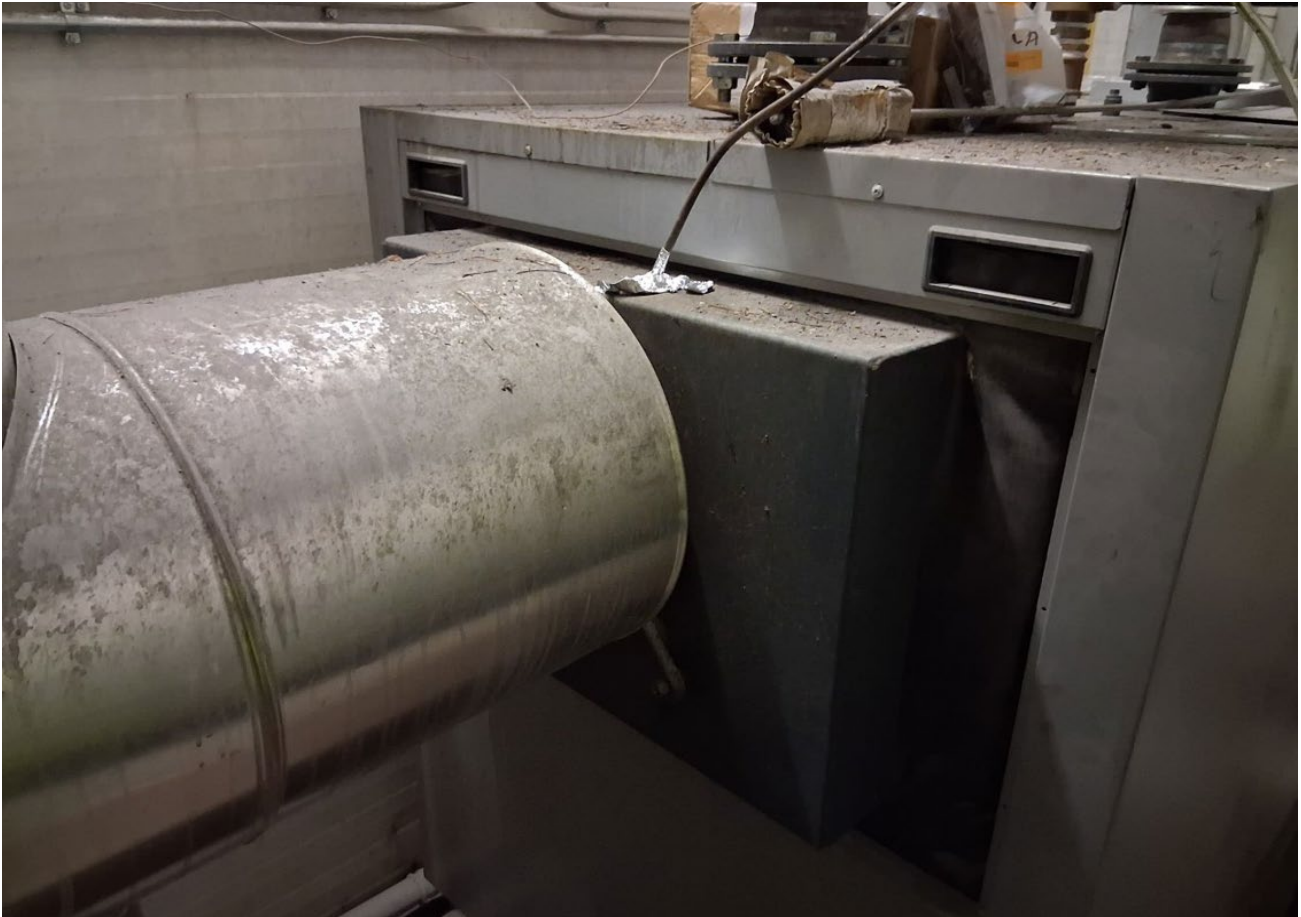
Kuva 1. 560 kW kattilan mittauspaikka
