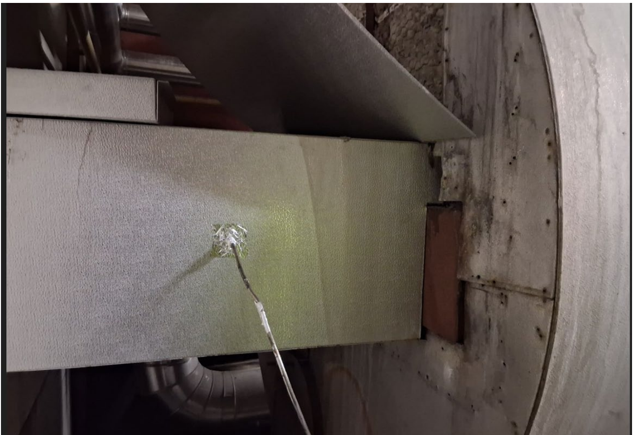
Kuva 2. 5,8 MW kattilan mittauspaikka
