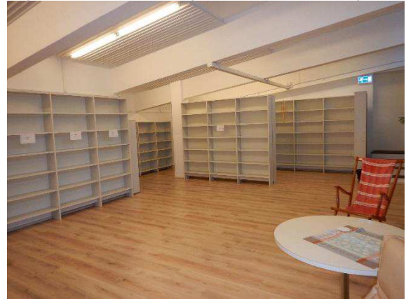
Kuva 4. Tilojen vieressä sijaitsee luokkatila, jonka lattiapinnoitteena on laminaatti. Huone on toiminut aiemmin liikuntasalina, joten huoneen lattia on korotettu.
