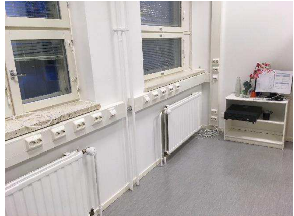
Kuva 2. Yleiskuva tiloista. Huoneesta otettiin VOC2-näyte. Huoneen alla on ryömintätilainen alapohja.
