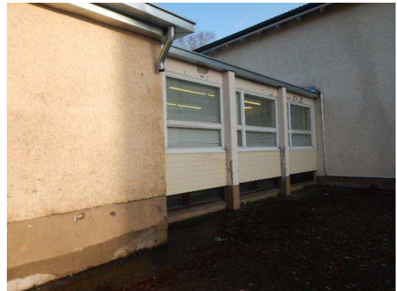
Kuva 6. Yleiskuva tilojen toisesta päästä. Tilojen ulkoseinärakenne on uusittu..
