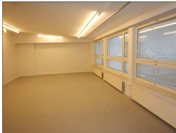
Kuva 3. Tutkittujen tilojen toisessa päässä lattiana on pinnoitettu betonilattia. Huoneen alla sijaitsee kellaritilat.
